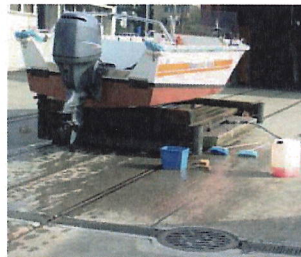
Washplatz mit Anschluss an die Kläranlage
